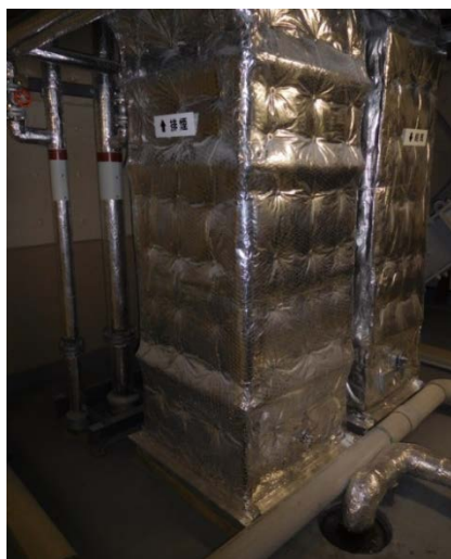
排煙風道の断熱措置の例
