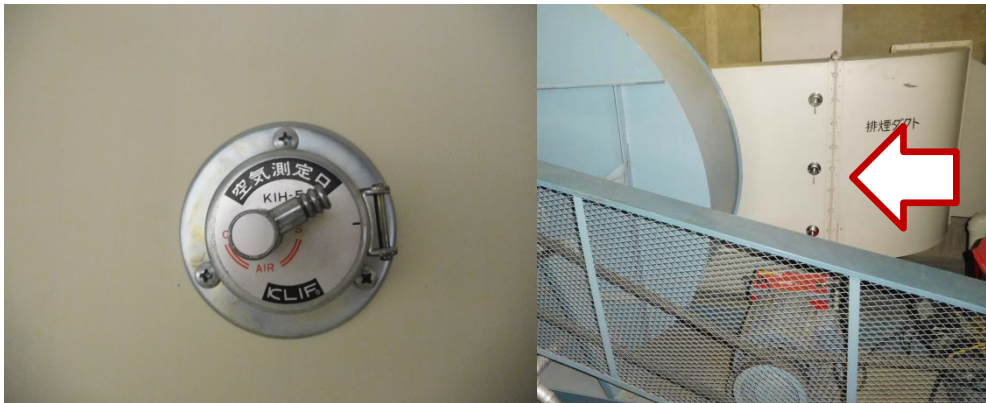
直管部分が短い風道に設けられている空気測定口の例
