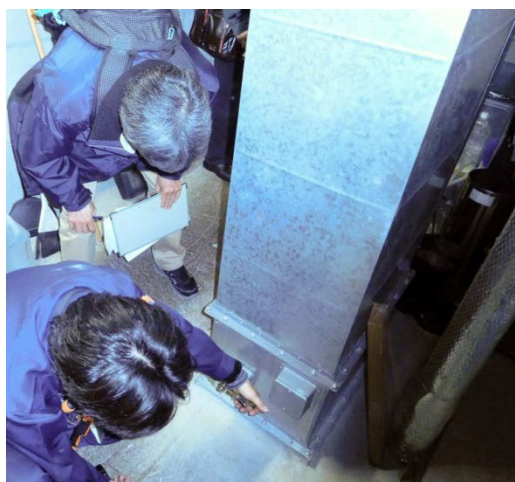
防火ダンパーの作動の確認状況
