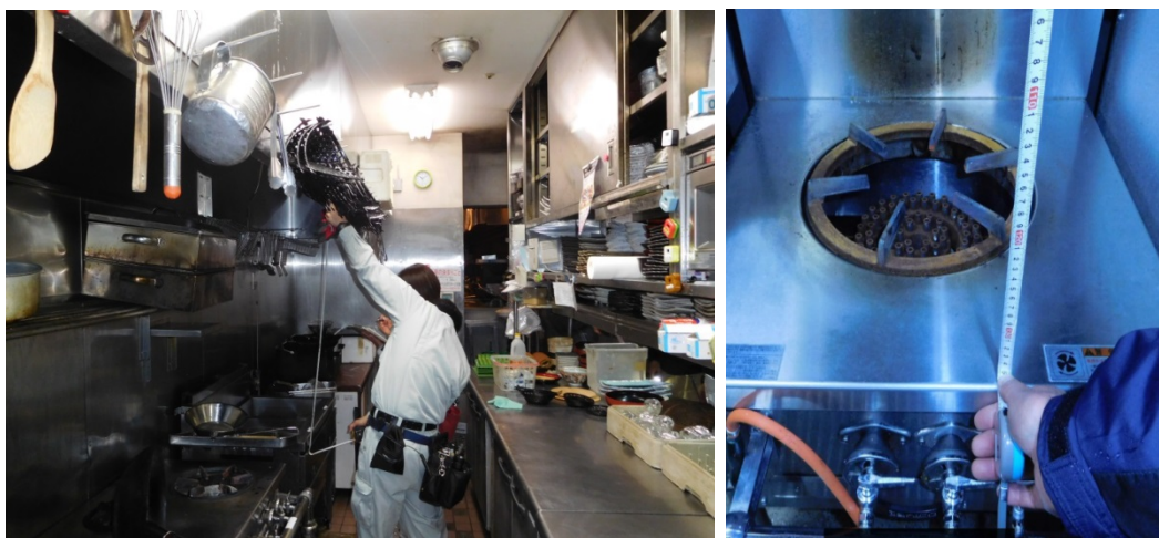
火源等から排気フードの下端までの高さの計測状況
