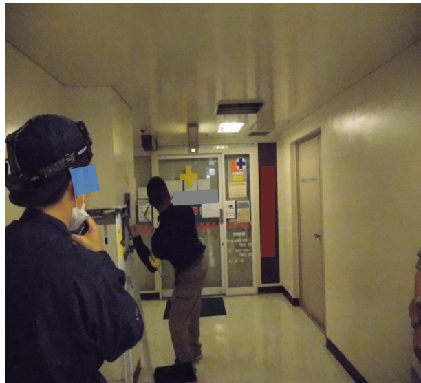
手動開放装置と連動して排煙口が開放することの確認状況
