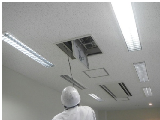
中軸回転の排煙口の風速測定状況
