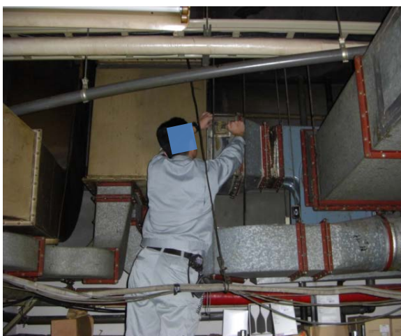
防火ダンパーの作動の確認状況
