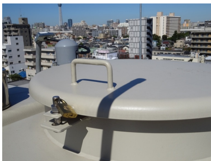
飲料水用給水タンクのマンホールの南京錠による施錠の例
