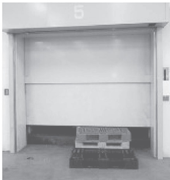
写真-1 5階エレベーター乗り場
