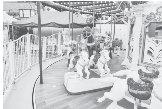
写真-4 回転舞台と接する床との隙間若しくは段差の状況 (写真提供：浅草花やしき)
