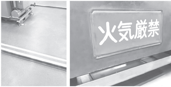
写真-2 防油堤、標識
